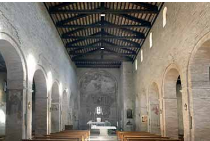
Visione della navata maggiore della chiesa abbaziale di Summaga
