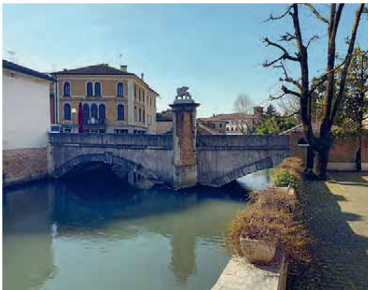
Portogruaro, pennone del ponte di Sant'Andrea (foto M.V. Peressini)
